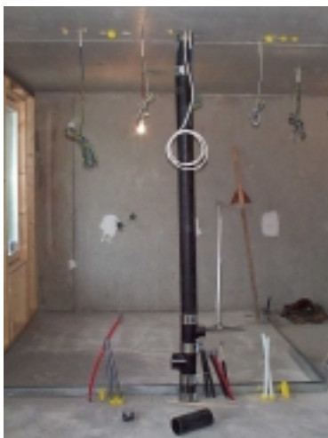
Väggförlagd MA-stam före väggregelresning.
