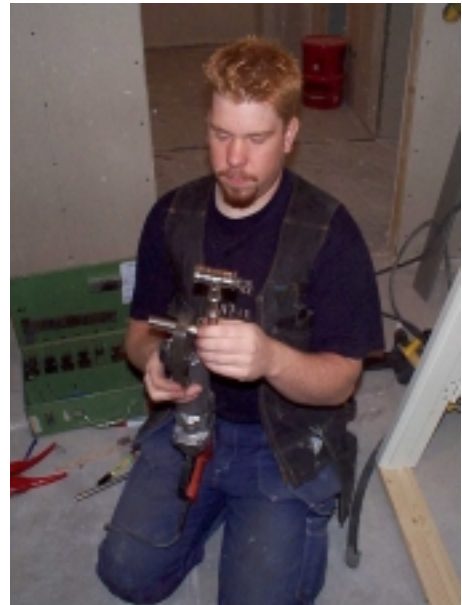
Elddrivet pressverktyg för rostfritt, tämligen stort, används (ovan) helst ”i det fria”.
