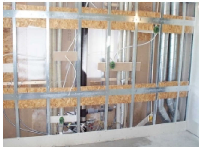
Stålregelvägg mellan kök och badrum före gipsskiveinklädnad.
