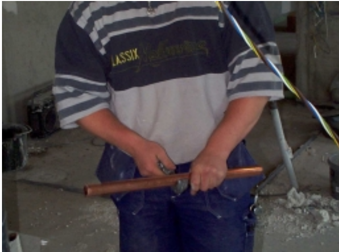
Kapning sker med rörkap (trissa), varefter rörändarna dornas upp (kalibreras) före
