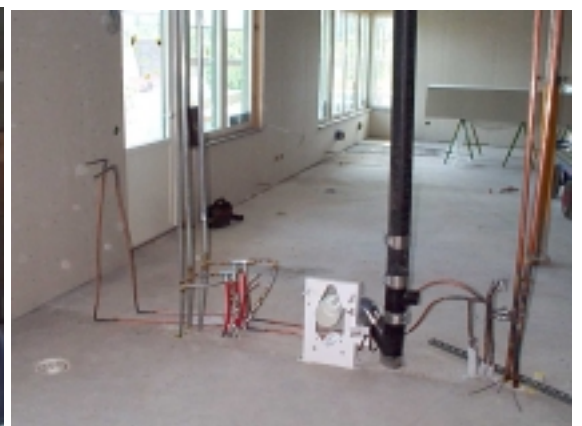
Färdigt kopparrörsmontage före innerväggsresning.
