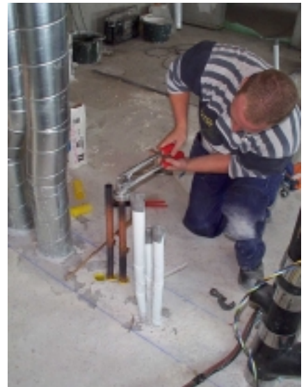
Kapning sker med rörkap (trissa), varefter rörändarna dornas upp (kalibreras) före
