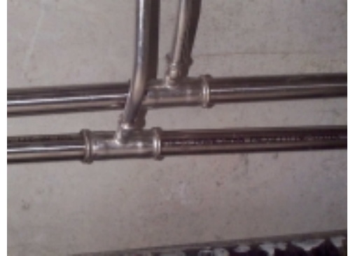
Rostfria T-rör med gummiringssmuff.
