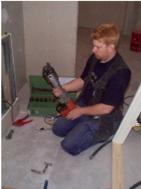
Elddrivet pressverktyg för rostfritt, tämligen stort, används (ovan) helst ”i det fria”.
