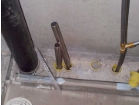
Rostfri stam ovan bjälklagsgenomföring.
