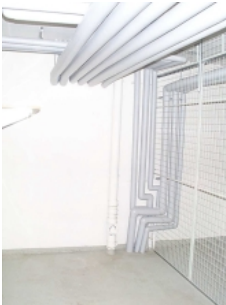
Färdig överisolerad rördragning i källartak.
